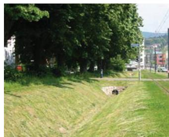
**AVANTAGES** : Les fossés peuvent facilement être raccordés aux canalisations des riverains et sont, de par leur orme, peu sensibles aux détériorations liées au stationnement ou au franchissement.
